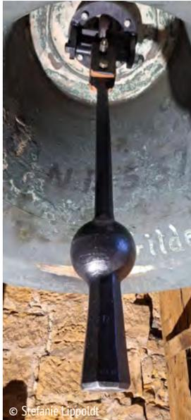
Ledereinband direkt in der Haufe eingebunden ist. Das dadurch keine definierte Führung für den Klöppel vorgegeben ist, kommt es zu diesen undefinierten Schlingerbewegungen.
